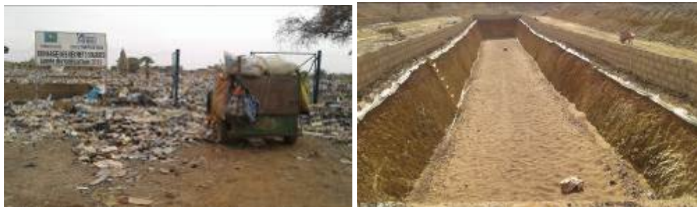
La décharge de Ziniaré (gauche) et une loge en construction sur la décharge de Kaya (droite)
