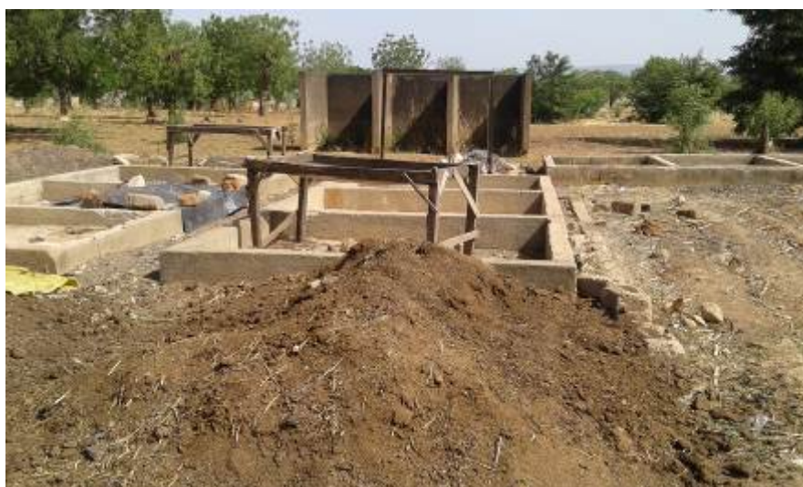
Vue de la plateforme de compostage de JAD/Comoé
