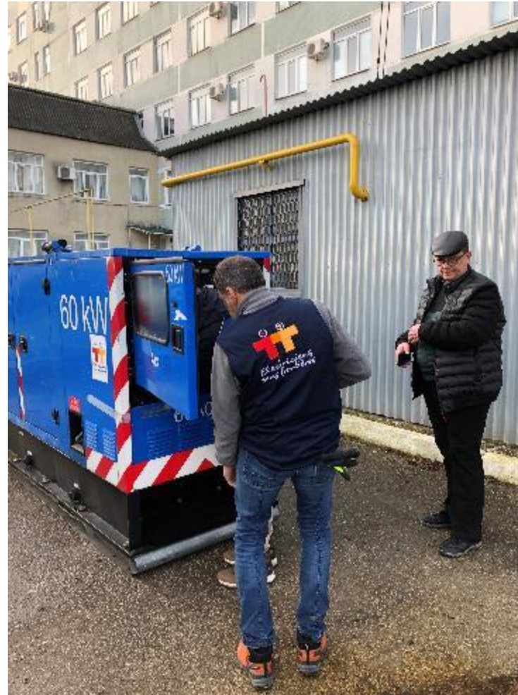
Intervention à l'hôpital régional de Donduseni
